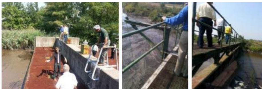
Fig. 4.1: Inspección física de la infraestructura actual de reducción de riesgos. Los equipos asignados por el NJDEP se han empeñado en clasificar el impacto del huracán Sandy en bermas, compuertas para marea e infraestructura de reducción de riesgos existente. La inspección física es crucial en la evaluación que realiza el Estado sobre la condición actual de las medidas de protección para identificar las reparaciones necesarias, así como la oportunidad de mejorarlas para abordar futuros eventos climáticos extremos y maximizar la inversión federal.
